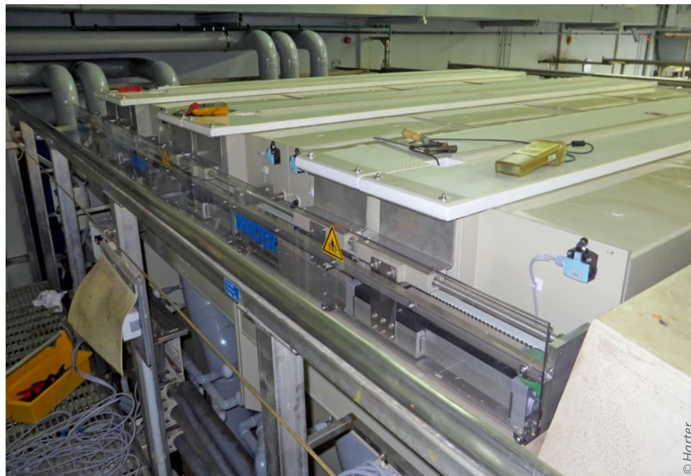
Einbau der Trockner
